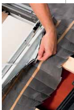
Alátétfólia vízelvezető csatornával
